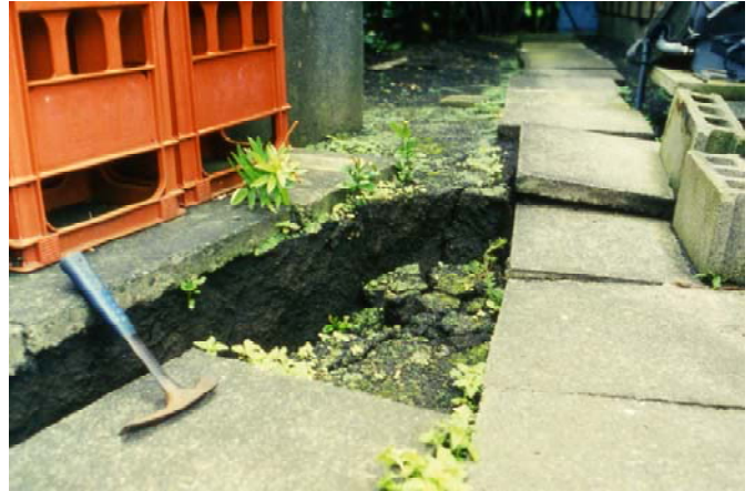
写真3 地割れ（阿古地区）
