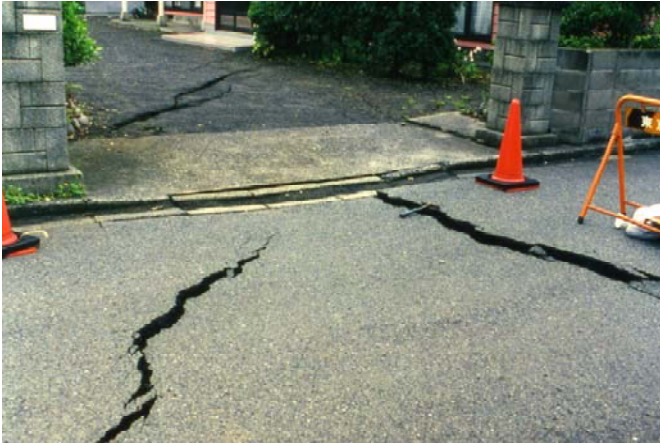
写真2 地割れ（阿古地区）
